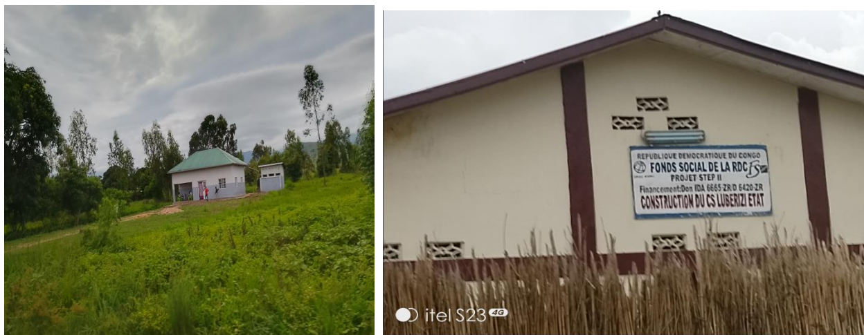
Figure 31: bâtiments sanitaires construits par le FSRDC
