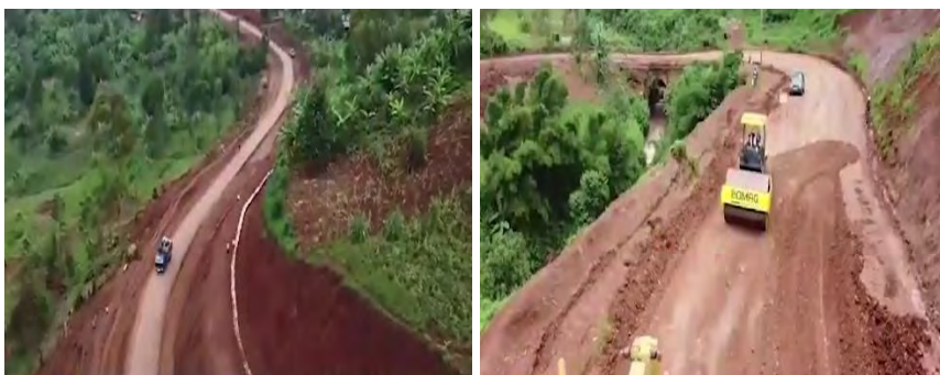
Figure 22: quelques routes en pleine réhabilitation sur le tronçon de Kamyola.
