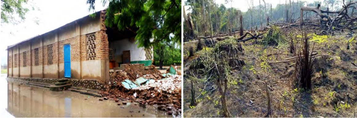
Figure 30: Illustration des inondations et déforestation dans le Sud-Kivu :
