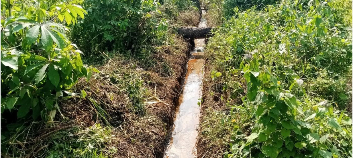
Photos 5 : Canalisation des eaux
