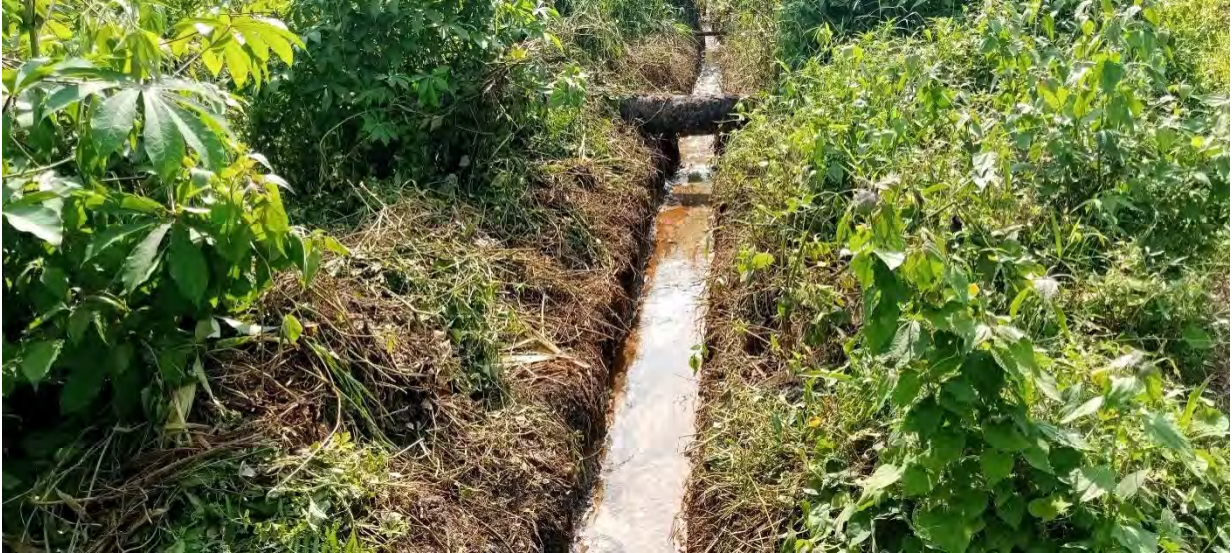
Photos 5 : Canalisation des eaux
