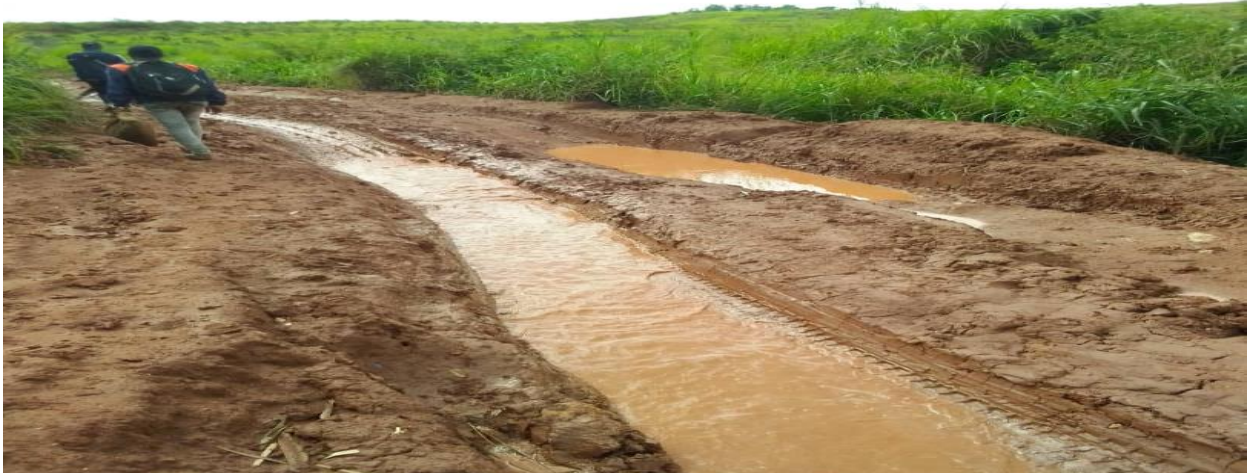
Photo n°9. Voie d'accès au site Zamba
