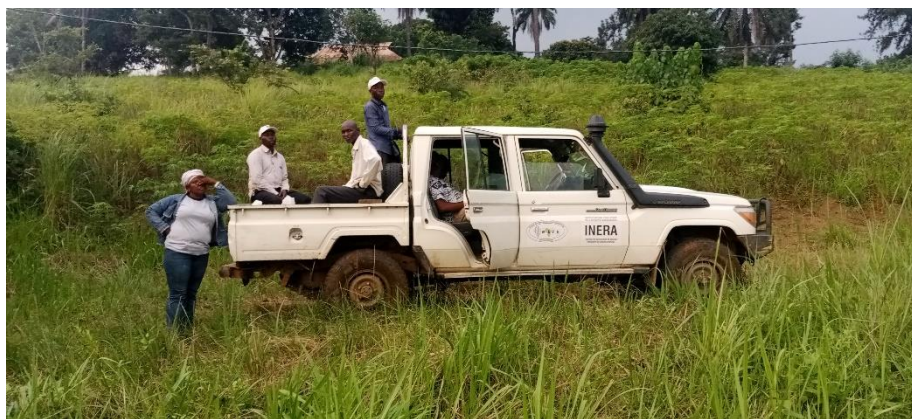
Photo 11. Site de construction de l'entrepôt
