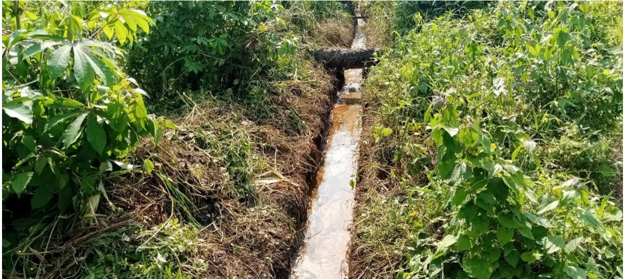
Photo 3 :. Canalisation des eaux
