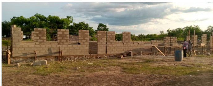
Vue de la construction d'une école au Nord Ubangi (STEP 2)
