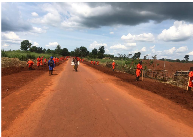
Réhabilitation des voiries à Gbadolite/Par la méthode HIMO (STEP 2)
