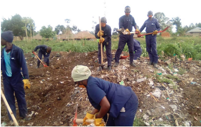
Les bénéficiaires THIMO assainissent l'axe de l'hôpital général d'Ariwara en Ituri.
