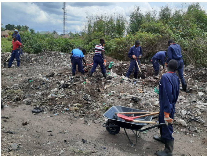
Les bénéficiaires THIMO assainissent l'axe de l'hôpital général d'Ariwara en Ituri.
