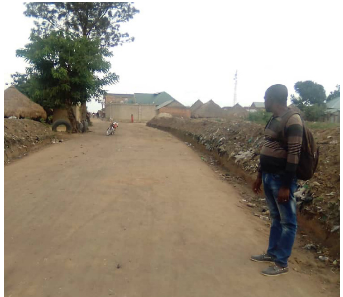
Vue du changement de l'axe de l'hôpital général d'Ariwara après les travaux HIMO du FSRDC.
