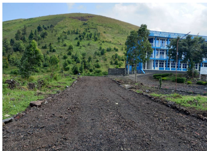
La route menant vers l'ISC Mugunga à Goma très accessible après les THIMO/PRSMVE
