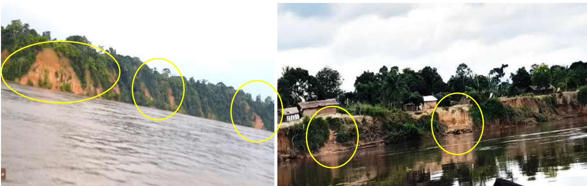
Figure 37 : Menace des villages et couvert végétal situés le long des rives du fleuve Congo par des nombreuses têtes d'érosion.
