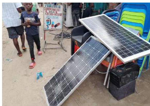
Figure 57: Usage de panneaux solaires à Ayonge.
