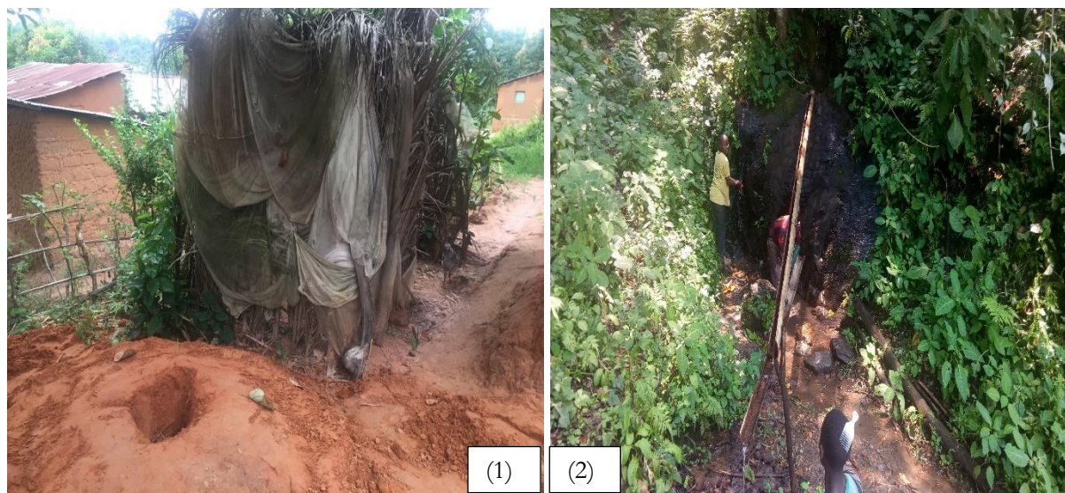
Photo 3. Toilette en construction et douche pour un ménage PA à Kananga ville (1) et source d'eau pour les PA à Walikale (2)
