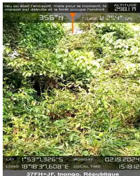
Photo 3 : Entrepôt en construction abandonné, INERA Ikalata, Mai-ndombe
